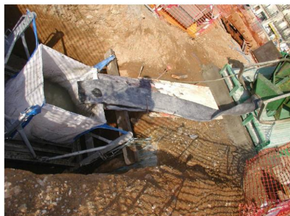
FIGURE 3 - FOSSE DE NETTOYAGE ET DE DECANTATION DES BENNES BETON
