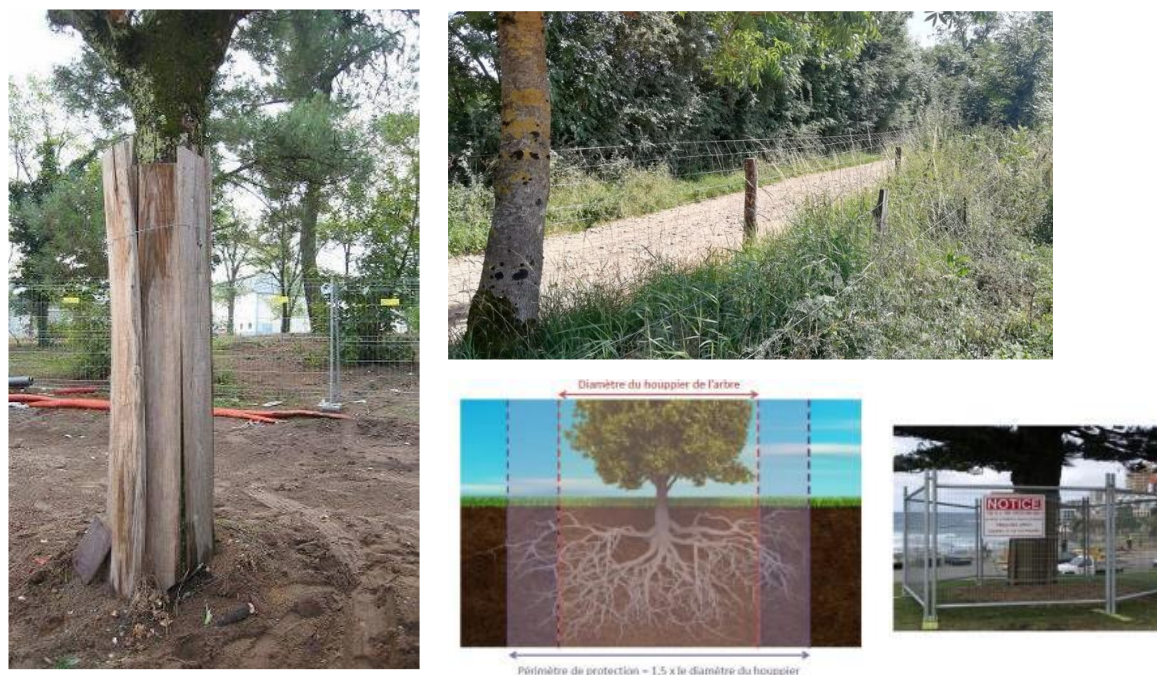
FIGURE 10 - PROTECTION DES ARBRES SUR LE CHANTIER
